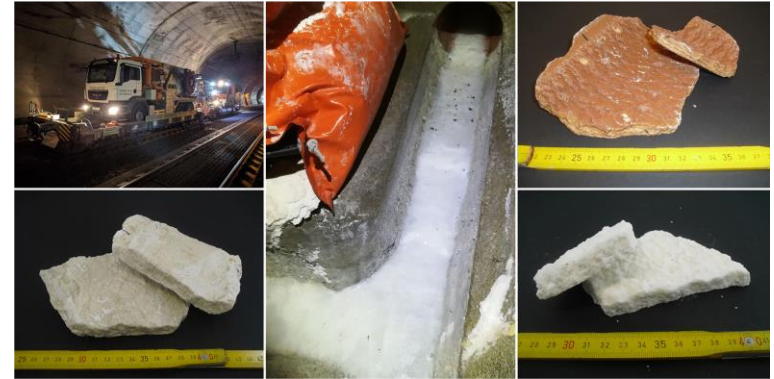
Versinterungen in Drainagerohre
