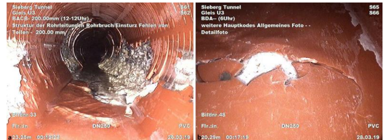
Schäden durch exzessive Reinigungsarbeiten
